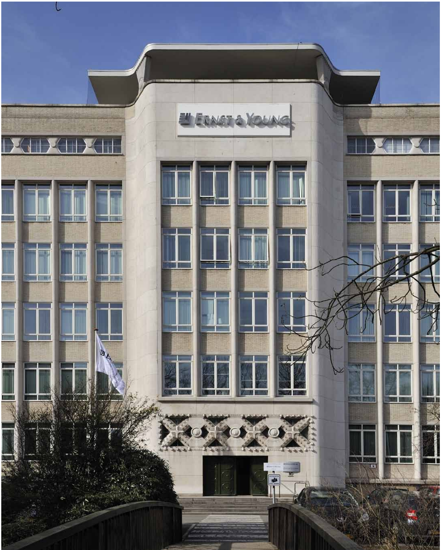
Het kantoorpand aan de Wassenaarseweg in Den Haag is een van de monumentale panden die door Bouwfonds REIM zal worden verduurzaamd. De verduurzaming zal onder andere bestaan uit een warmte- en koudeopslag onder het kantoorgebouw.
